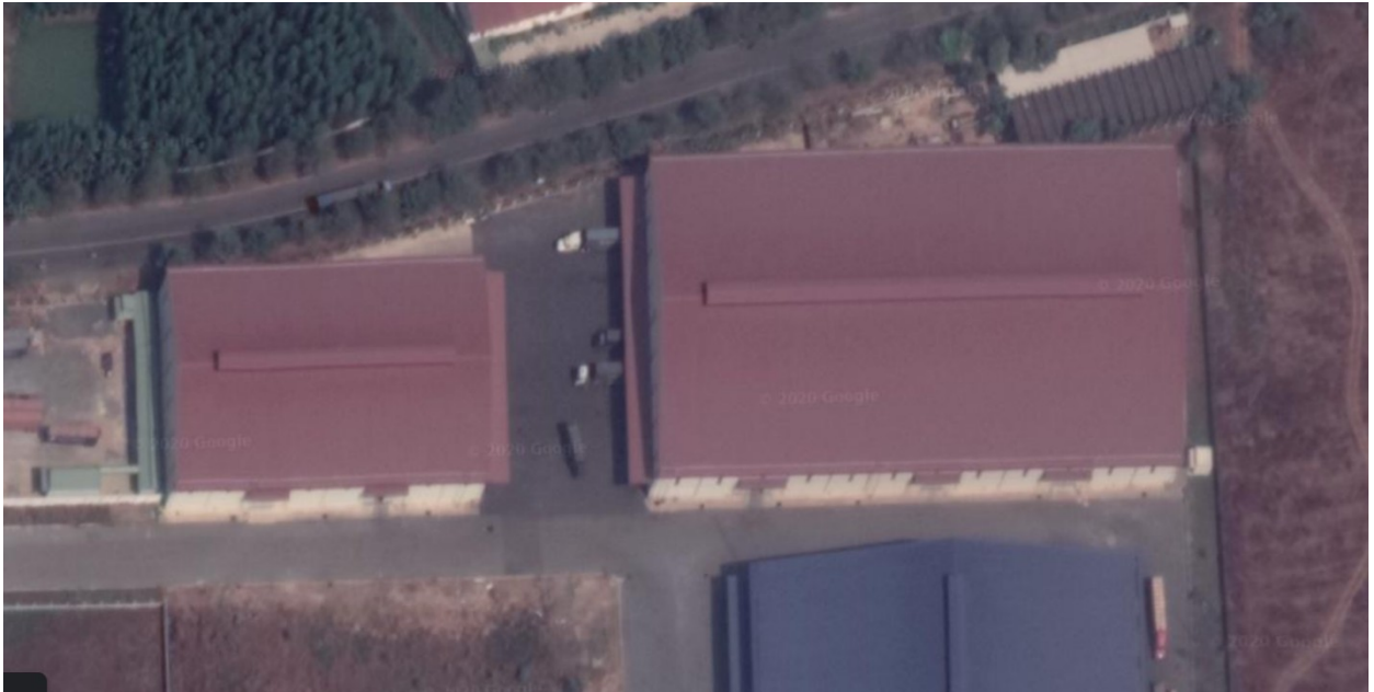
Hình 2.1 Khu vực lắp đặt pin NLMT
