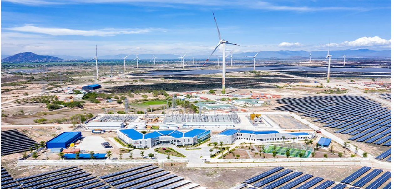
Hình 1.13 Nhà máy điện gió Trung Nam (Nguồn: Công ty Cổ phần Đầu Tư Xây dựng Trung Nam)
