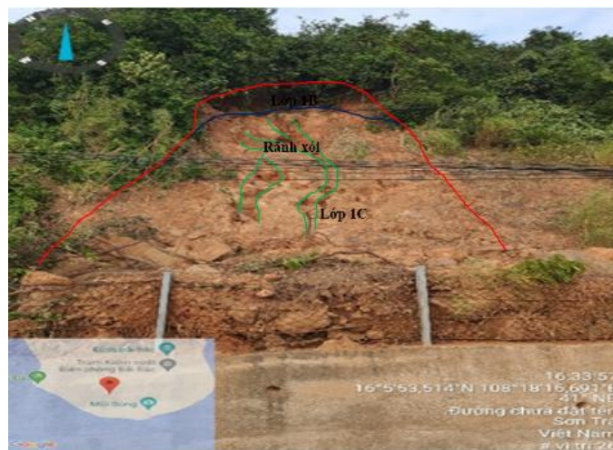
Hình 2.27. Cấu trúc địa chất khối xói sạt S26
