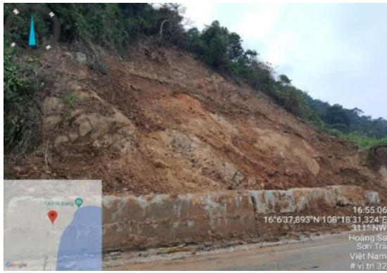
Đoạn 18 Sụt lở, đá lăn, hư hỏng tường chắn vị trí S32 (taluy đường)
