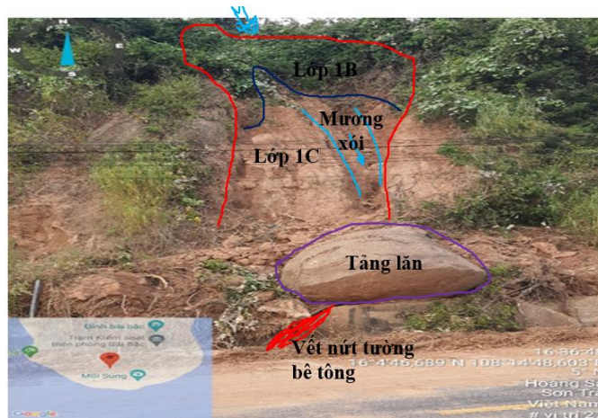
Hình 2.28. Cấu trúc địa chất khối xói sạt S27
