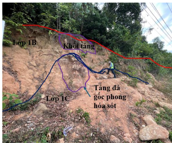
Hình 2.14. Cấu trúc mặt cắt khối sụt S6
