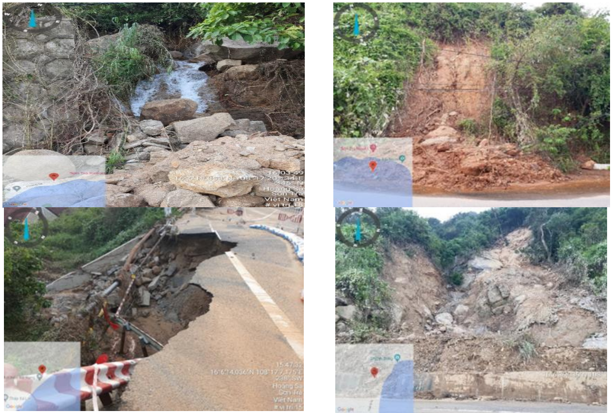
Hình 3.1. Các dạng trượt lở điển hình dọc tuyến đường
