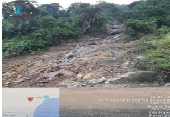
Đoạn 18 Xói sụt vị trí S34 (Đá lăn taluy đường), hư hỏng tường chắn
