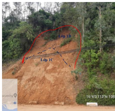
Hình 2.9. Hình ảnh vị trí khối sụt S1 và cấu trúc địa chất khối sụt
