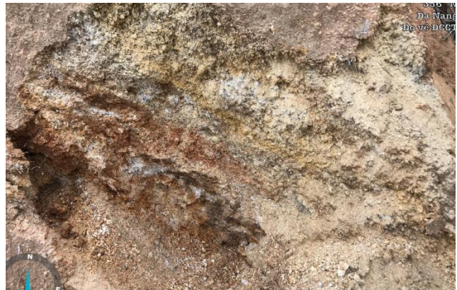
(b)– Thành phần lớp 1C vách lộ chân taluy điểm S6 đoạn 3
