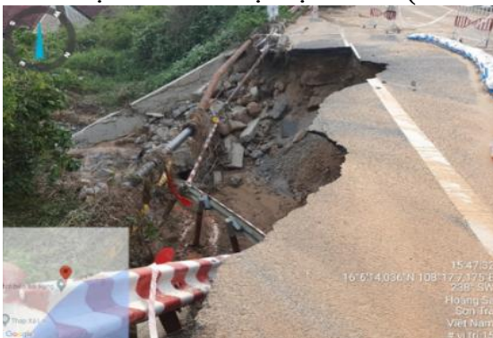
Đoạn 9 Sụt lở nền mặt đường và taluy âm tại vị trí S15
