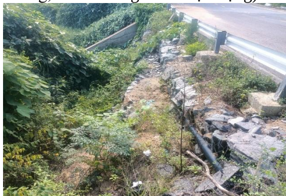
Đoạn 9 Sụt lở nền mặt đường và taluy âm tại vị trí S15
