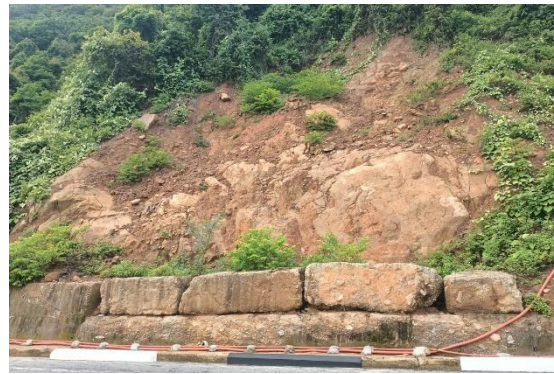
Đoạn 18 Sụt lở, đá lăn, hư hỏng tường chắn vị trí S32 (taluy đường)
