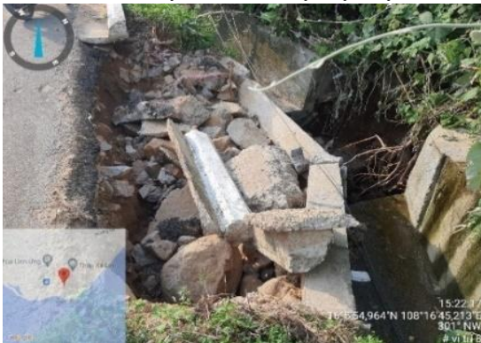
Đoạn 4 sụt chân công phía thượng lưu, hư hỏng rãnh thoát nước dọc tại vị trí S8
