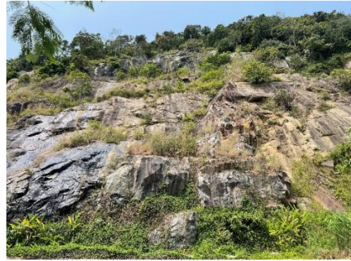
Hình 2.6. Vách lộ chân taluy dương phân bố đá thuộc lớp 2B khu vực nghiên cứu
