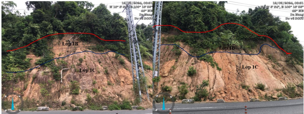
Hình 2.15. Cấu trúc mặt cắt khối xói sụt S7
