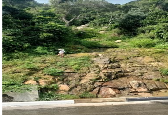
Đoạn 18 Xói sụt vị trí S34 (Đá lăn taluy đường), hư hỏng tường chắn
