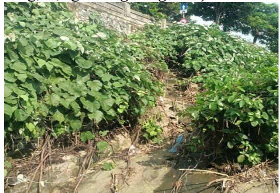
Đoạn 4 sụt chân công phía thượng lưu, hư hỏng rãnh thoát nước dọc tại vị trí S8
