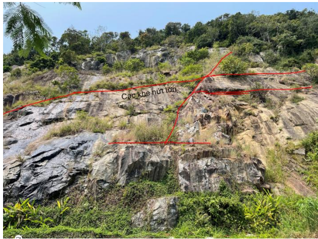
Hình 2.30. Cấu tạo mái dốc đá điểm S29
