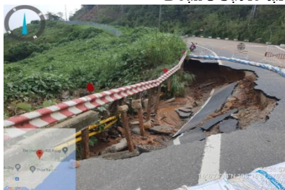
Đoạn 6 Sụt lở nền mặt đường và taluy âm tại vị trí S12
