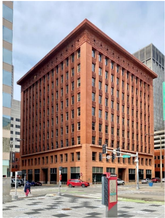
Hình 3.2b: Tòa nhà Wainwright Building (hoàn thành 1891, KTS. Sullivan) [St]
