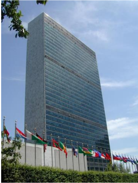
Hình 3.5a: Trụ sở Liên hợp quốc (hoàn thành 1952, KTS. Oscar Niemeyer) [St]
