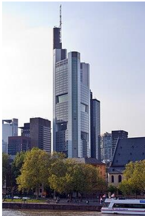
Hình 3.7b: Trụ sở ngân hàng thương mại Commerzbank (hoàn thành 1991, KTS. Norman Foster) [St]
