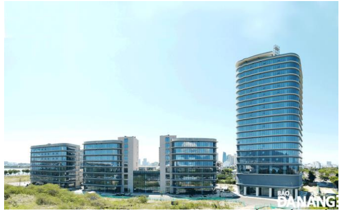
Hình 2.2b: Toà nhà Công viên phần mềm số 2 - Đà Nẵng [St]
