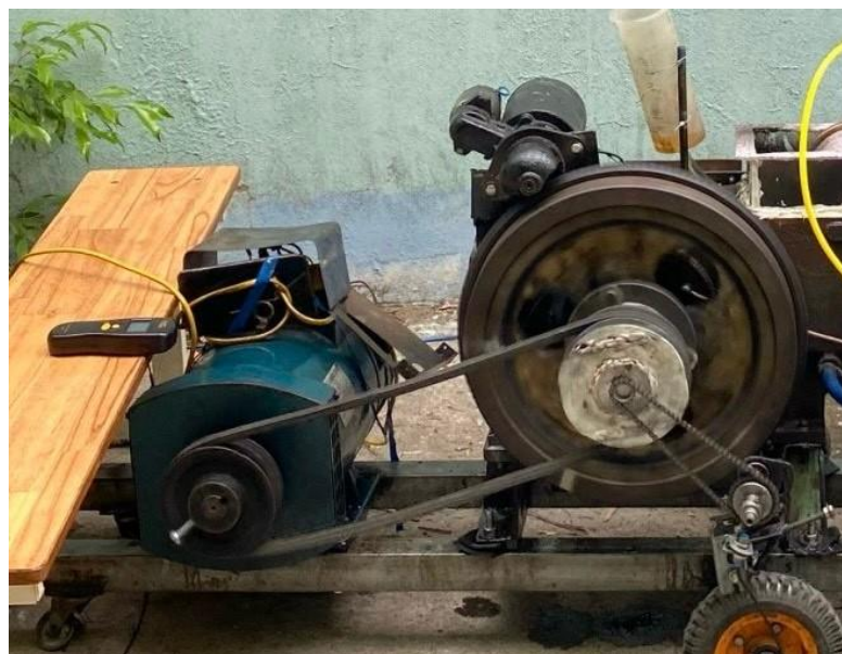
Hình 3.31 Lắp đặt máy phát điện
