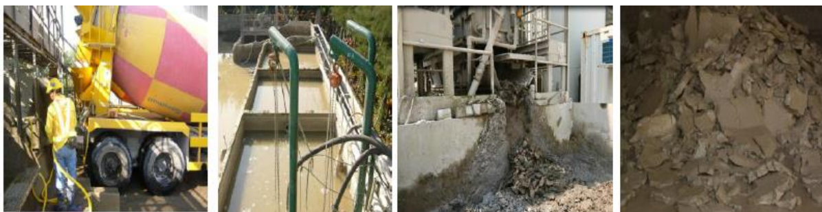
Hình 1.1 Quá trình hình thành bùn thải bê tông (BTBT) tại một trạm trộn BTXM ở Hong Kong [4]
