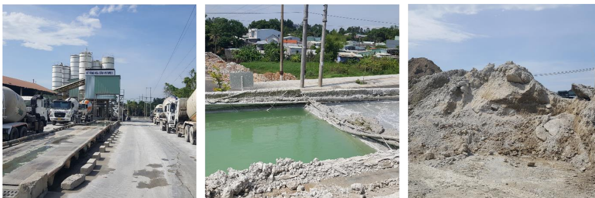
Hình 1.2 BTBT được thu từ các bể lắng và chất đống tại một trạm trộn BTXM ở TP. Đà Nẵng, Việt Nam
