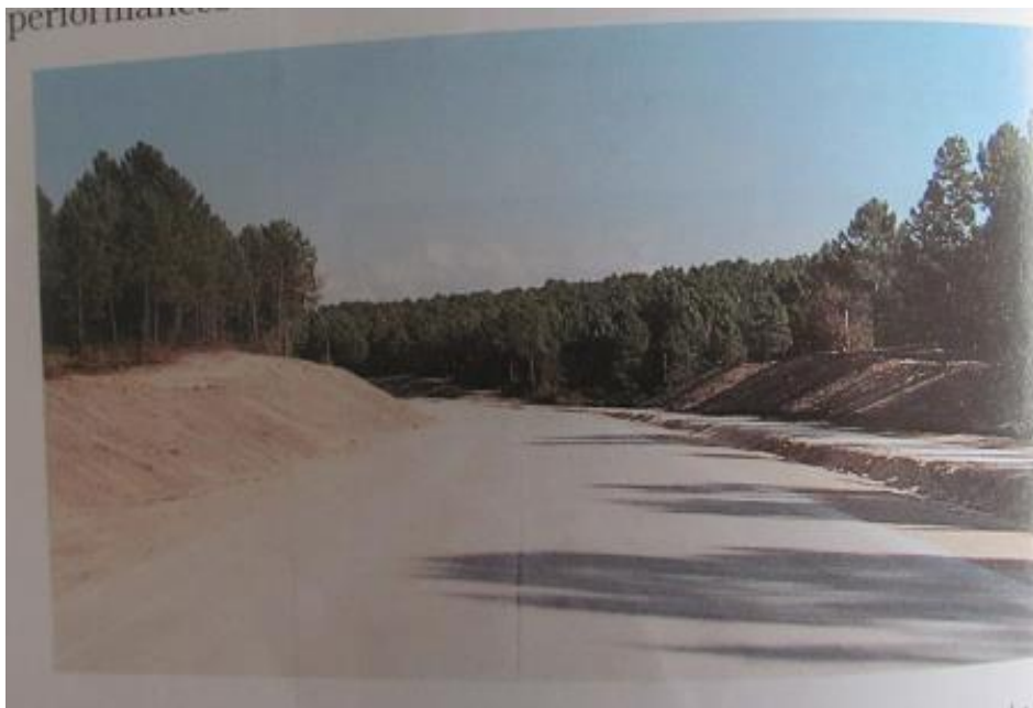
Hình 1. 11. Đường bê tông cát La teste et Le Pyla, ở tỉnh Aquitaine sử dụng cát bồi nhiễm mặn [79]
