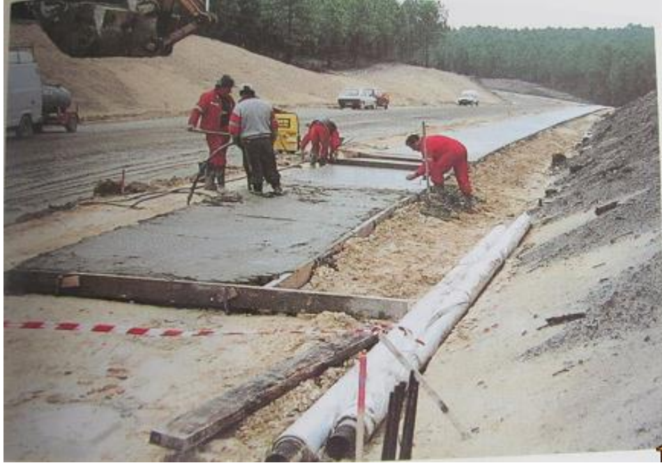
Hình 1. 9. Đường BTHN sử dụng cát đụn [79]
