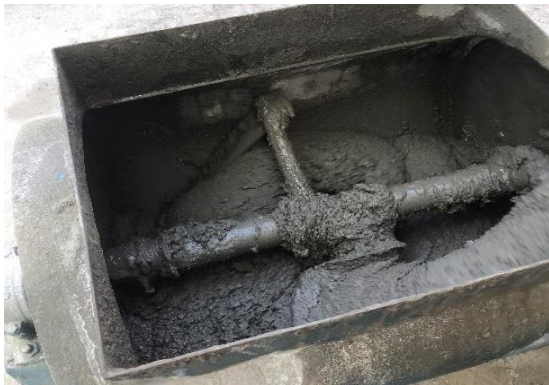
a) Công tác trộn bê tông
